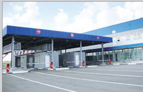
Многосторонний автомобильный пункт пропуска (МАПП). Республика Северная Осетия – Алания, пос. Нижний Зарамаг. 2008 г. Электромонтажные и пусконаладочные работы.
