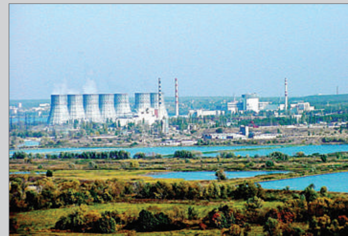
Нововоронежская АЭС. Воронежская область, 2010–2011 гг.
