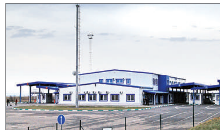
Многосторонний автомобильный пункт пропуска (МАПП). Ростовская область, г. Гуково. 2006 г. Электромонтажные и пусконаладочные работы.
