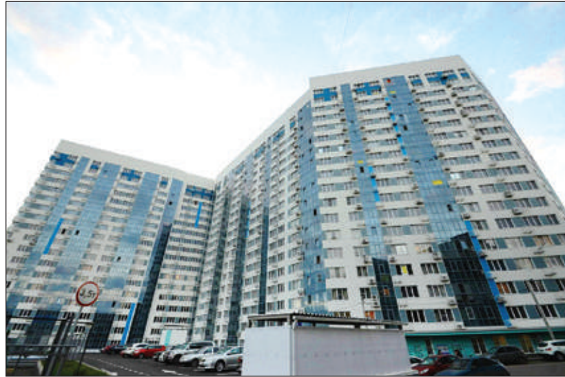
ЖК «Гвардейский». г. Ростов-на-Дону, 2010–2015 гг. Электромонтажные работы на объем более 50 000 м 2 (575 квартир), автостоянка на 140 машино-мест.
