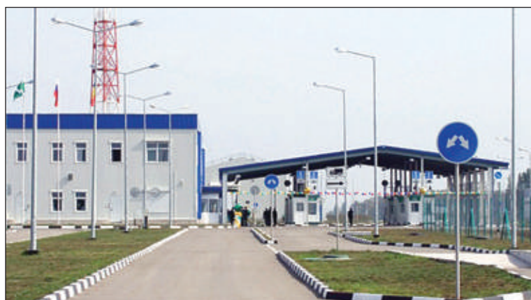
Многосторонний автомобильный пункт пропуска (МАПП). Ростовская область, г. Донецк. 2007–2008 гг. Электромонтажные и пусконаладочные работы.
