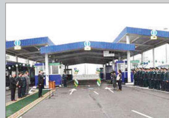
Многосторонний автомобильный пункт пропуска (МАПП). Ростовская область, с. АвилOVO-Успенка. 2008 г. Электромонтажные и пусконаладочные работы.
