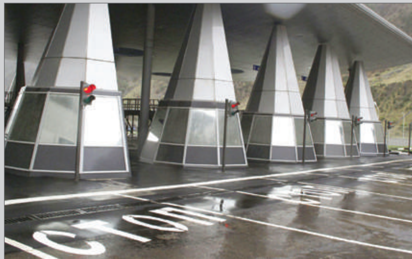
Многосторонний автомобильный пункт пропуска (МАПП). Республика Северная Осетия – Алания, пос. Верхний Ларс. 2008 г. Электромонтажные работы внутренних силовых, осветительных и розеточных сетей, демонтаж ДГУ Р600 и монтаж ДГУ SDMO.
