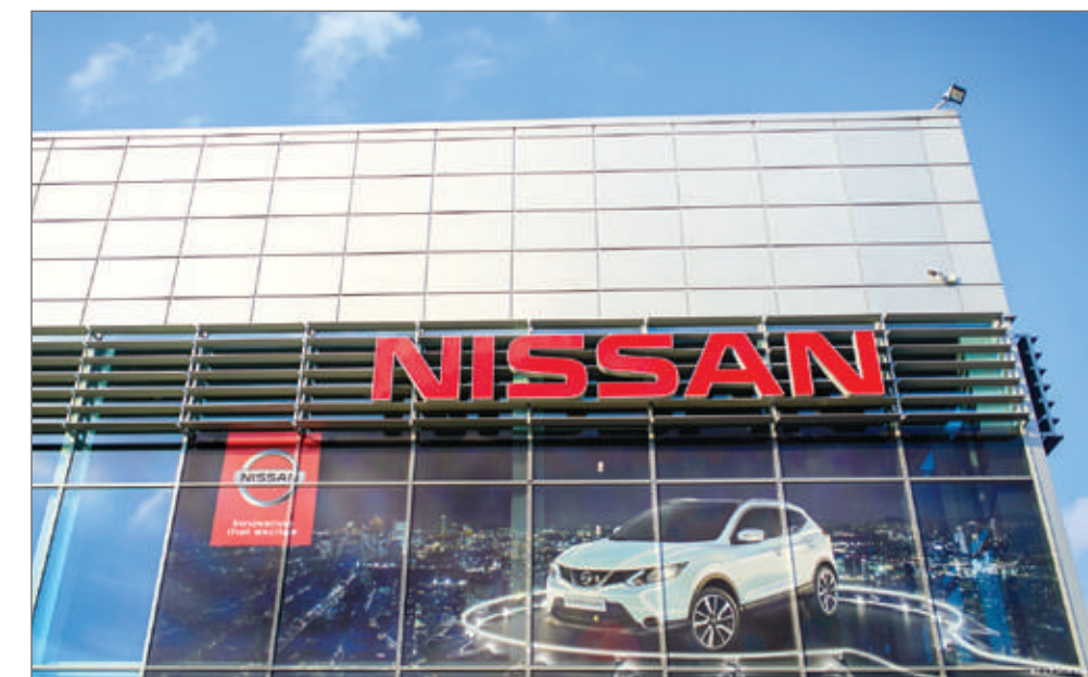
Автосалон «Орбита». Официальный дилер Nissan. г. Ростов-на-Дону. 2008 г. Выполнен весь спектр электромонтажных работ.
