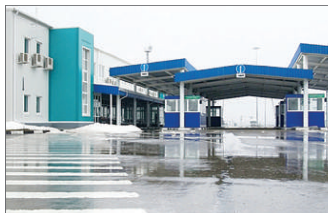
Многосторонний автомобильный пункт пропуска (МАПП). Ростовская область, пос. Матвеев Курган. 2008 г. Электромонтажные и пусконаладочные работы.
