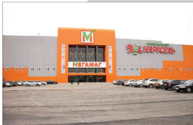
ТРЦ «Мега Маг». Гипермаркет «Карусель». г. Ростов-на-Дону. 2010–2011 гг. Электромонтажные работы.
