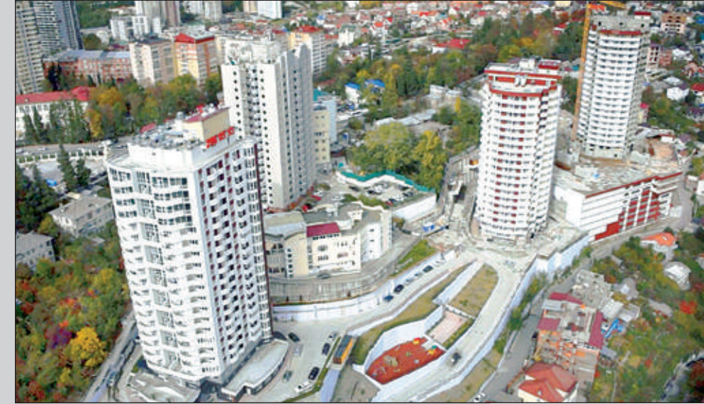
ЖК «Сияние Сочи». Краснодарский край, г. Сочи, 2013–2014 гг. Электромонтажные работы на объем 65 000 м 2 (695 квартир) и автостоянка на 427 машино-мест.
