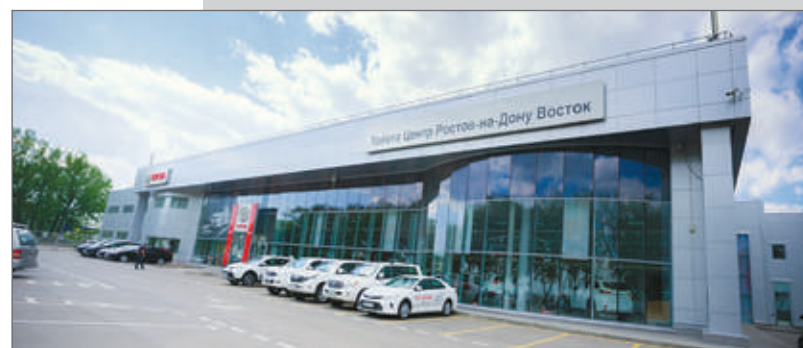
Тойота Центр Ростов-на-Дону Восток. Ростовская область, г. Аксай. Выполнен весь спектр электромонтажных работ.
