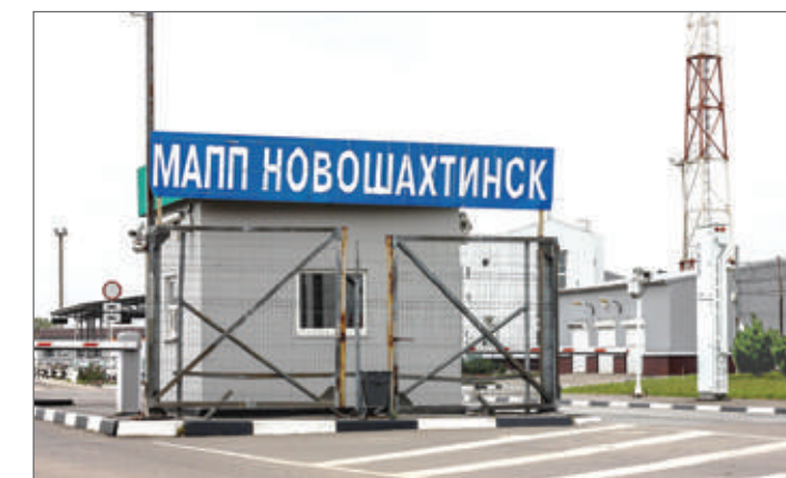
Многосторонний автомобильный пункт пропуска (МАПП). Ростовская область, г. Новошахтинск. 2004 г. Электромонтажные и пусконаладочные работы.
